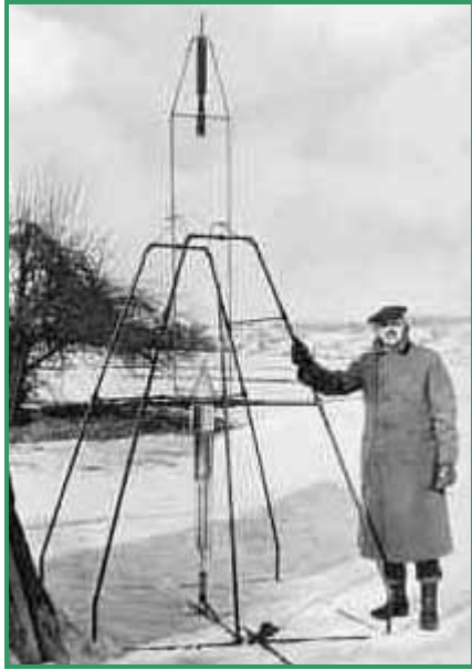
Testée le 16 mars 1926 dans le Massachusetts, la fusée de Goddard fonctionne 2,5 secondes et s'élève à 12,5 mètres. Le propulseur est situé au dessus et reçoit le carburant par deux conduits venant du réservoir, en bas
